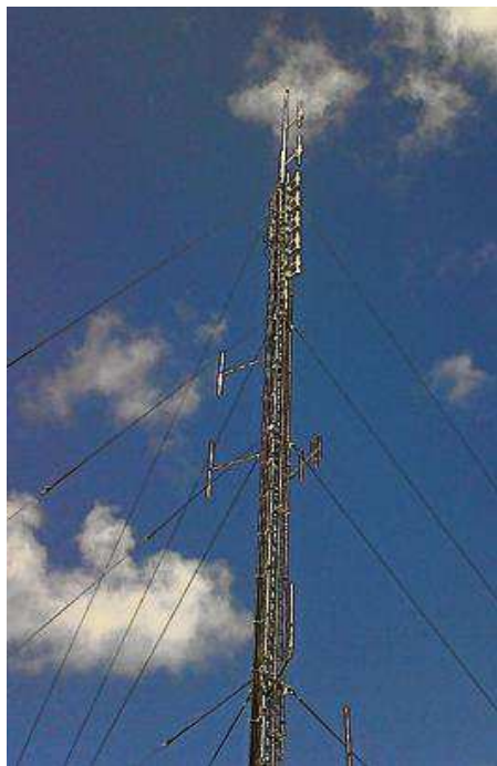
A Saint-Herblain, c'est un pylône de 26 mètres de haut qui abrite les émetteurs de la radio numérique terrestre.
